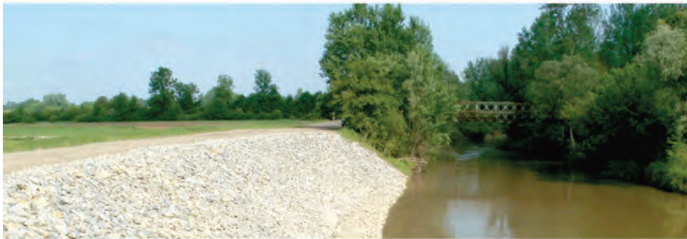
Завршена обалоутврда код моста између Дражевца и Пољана
