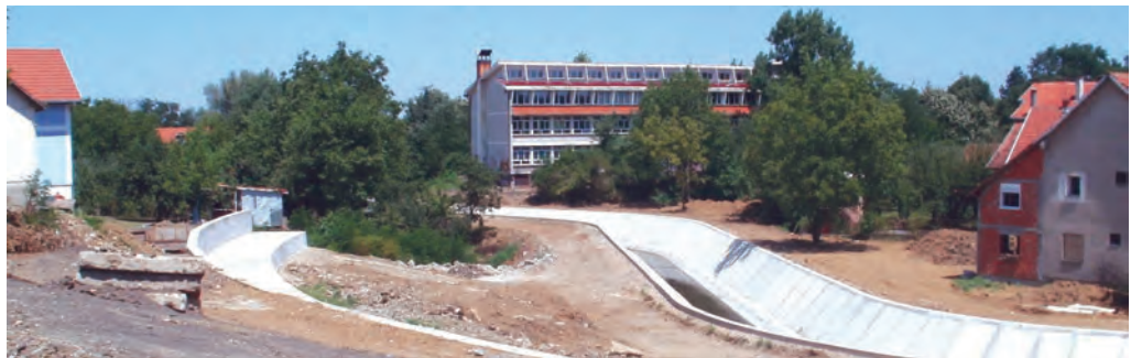
Потпорни зид и део корита Баричке реке
