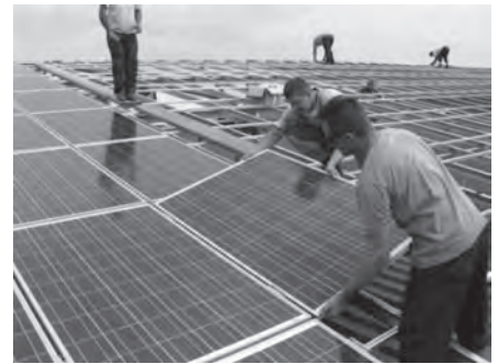
Монтажа соларних панела
