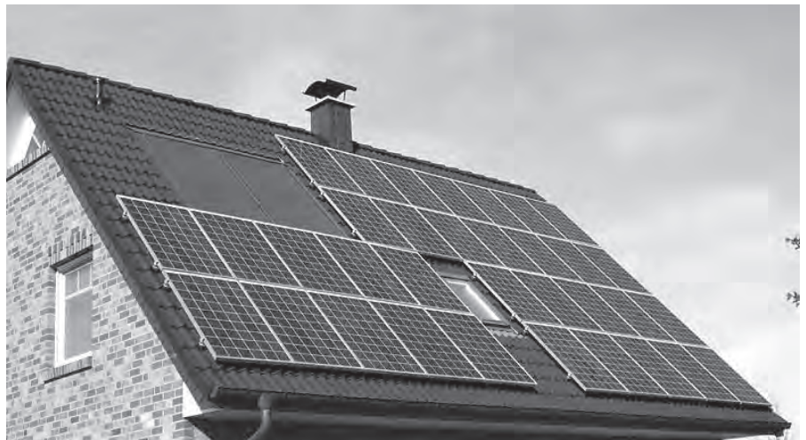
Фотонапонски систем уграђен у кровну конструкцију
