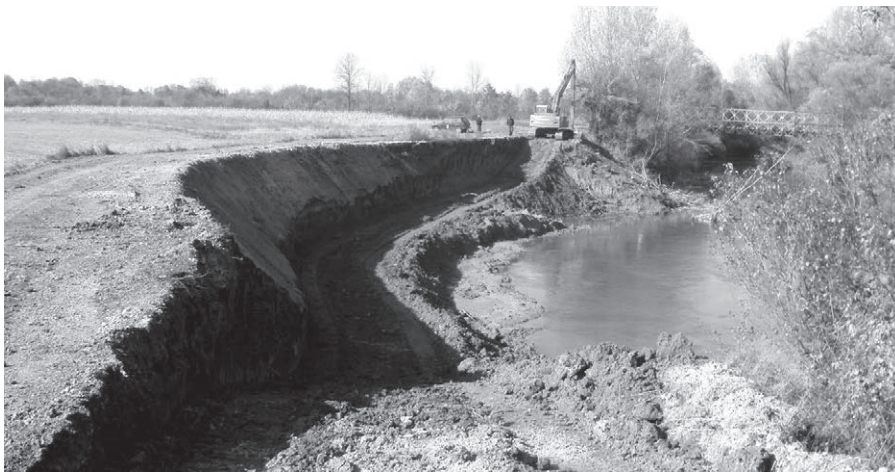
Изградња обалоутврде на Колубари код моста у Дражевцу, август 2011.
