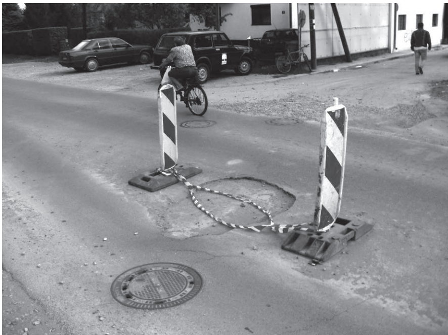
Последице инфилтрације подземних вода у канализацију
