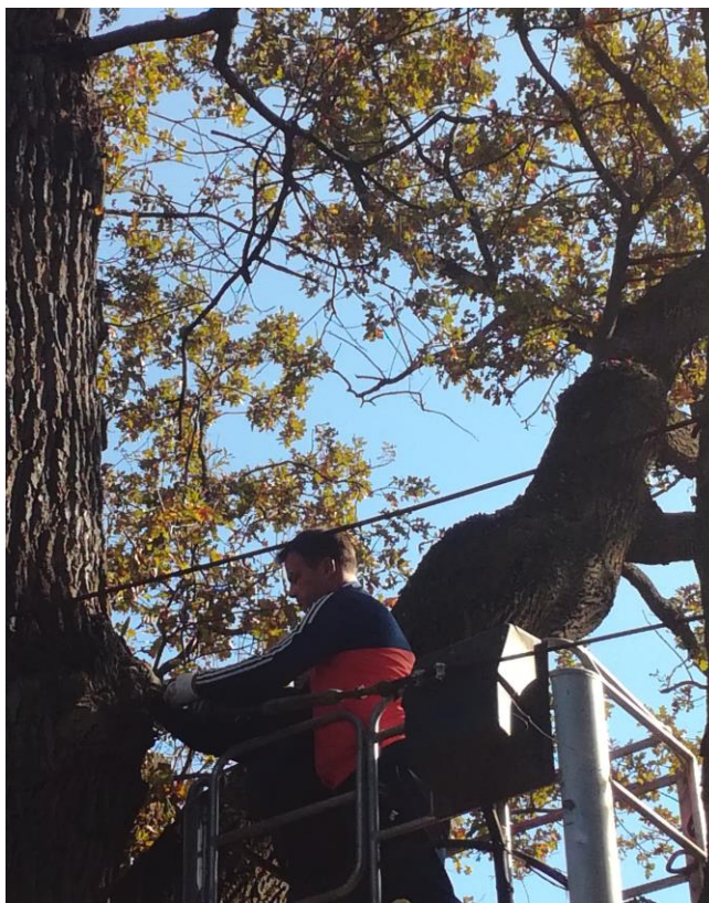
постављање сајли на заштићена стабла бр.2 и бр.3.
