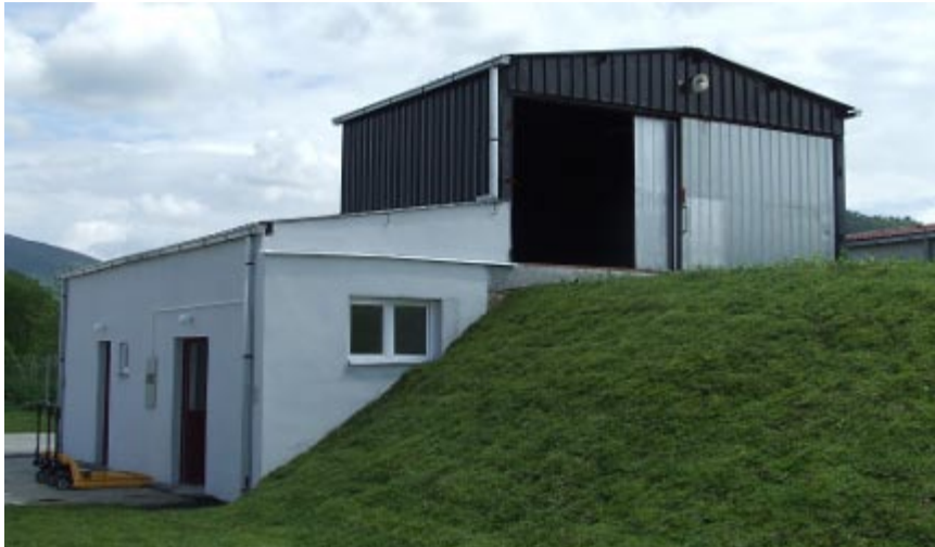
Слика 38 - Сабирни пункт (хладњача) за привремено складиштење кланичког отпада у Вршцу
